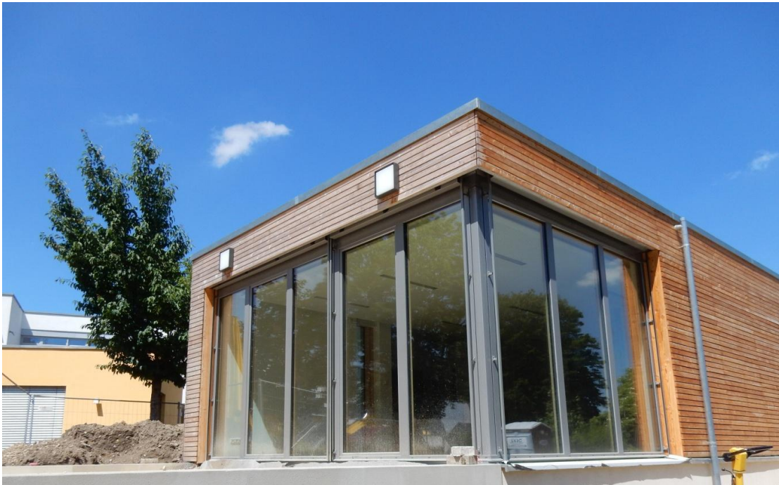
Auf der Wühre 13 (KaffCafe) nach den 2018 durchgeführten Umbaumaßnahmen
