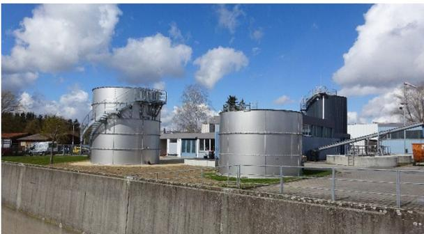
Abbildung 25: links Schlammstapelbehälter
