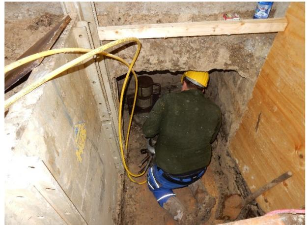
Abbildung 13: Arbeiter beim Pressen eines Pfahls
