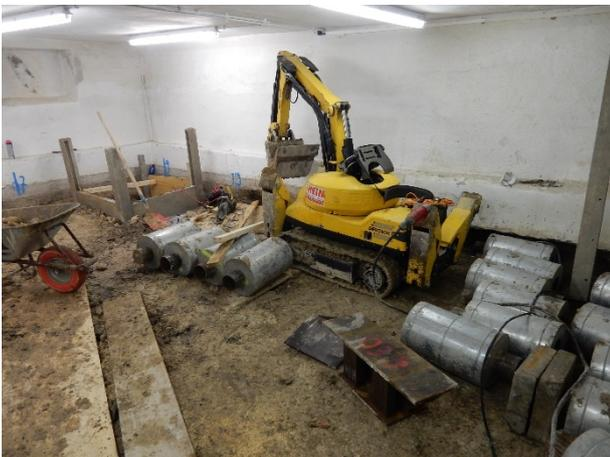
Abbildung 12: Bagger und Presspfahlsegmente im Keller des Rathauses
