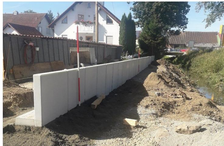
Abbildung 26: Hochwasserschutzmaßnahme am Erlenbach, Bauabschnitt 4 im Bau
