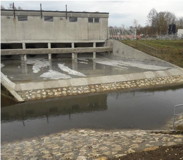
Abbildung 24: neues Auslaufgerinne am Hochwasserpumpwerk der Kläranlage
